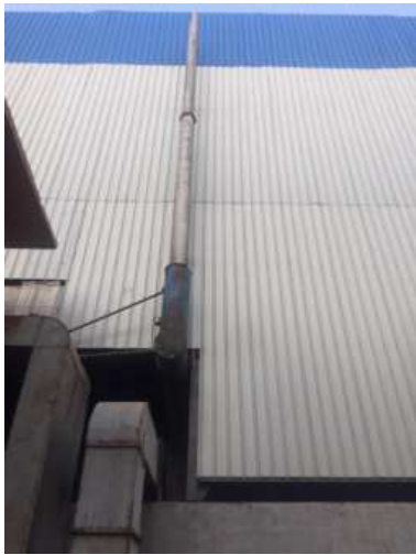
上料系统除尘器排气筒
