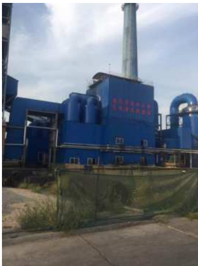
上料系统除尘器排气筒
